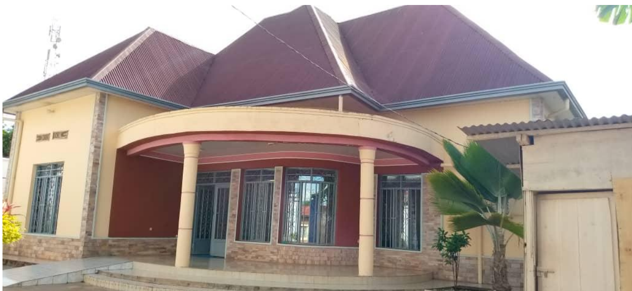
Figure 2: Bâtiment servant de bureau de l'antenne Makamba
